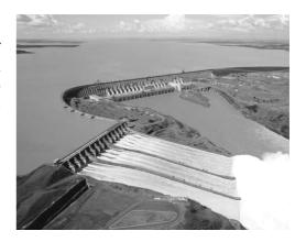
C 4.1.1 Pro Sekunde fließen durchschnittlich 525 m³ Wasser durch eine der Turbinen. Der Wirkungsgrad beträgt 89%.
