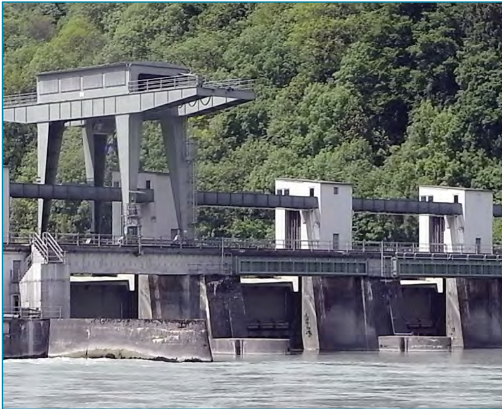
Typisches Wasserkraftwerk am Inn
