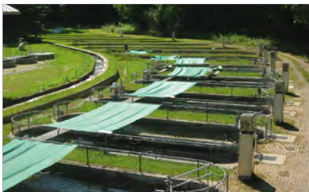
Becken einer Forellenzuchtanlage (Foto: LfL Starnberg)
