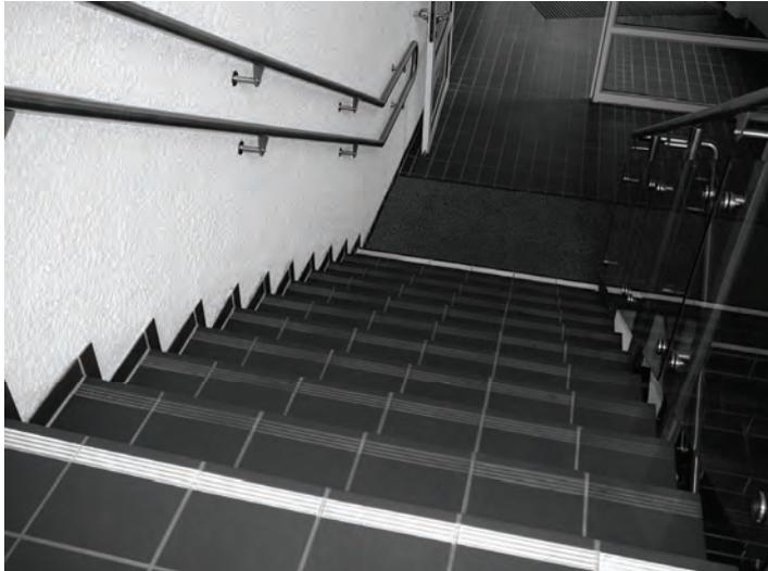
Abb. 9: Rillen kennzeichnen Stufenende; Farbstreifen weisen auf Anfang und Ende der Stufen hin; Teppich am Treppenabsatz kündigt Stufen an; Handlauf gibt Sicherheit
