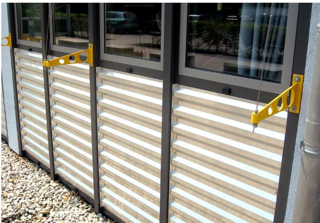
Abb. 4: Außenverkleidung einer Wand mit Aluminiumblech
