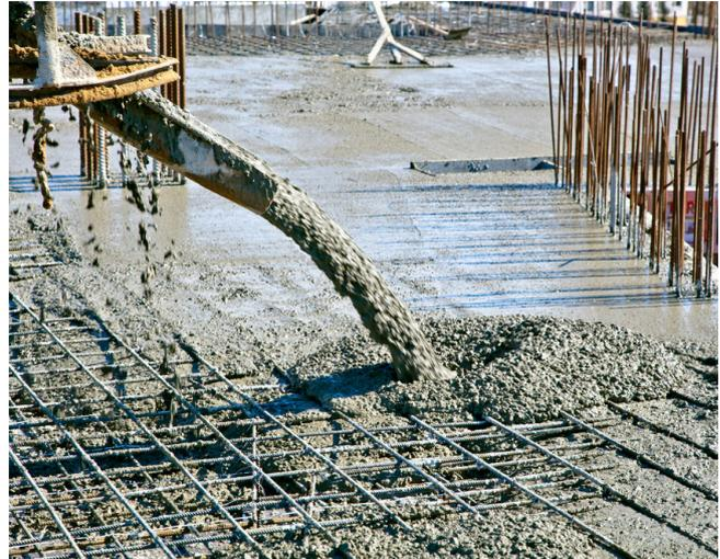
Abb. 3: Betonguss einer stahlarmierten Decke
