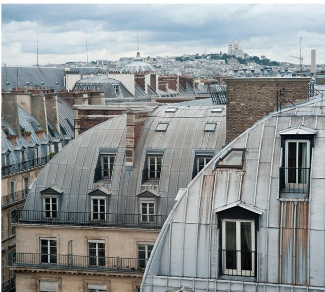
Abb. 6: Dachverkleidungen aus verzinktem Blech in Paris
