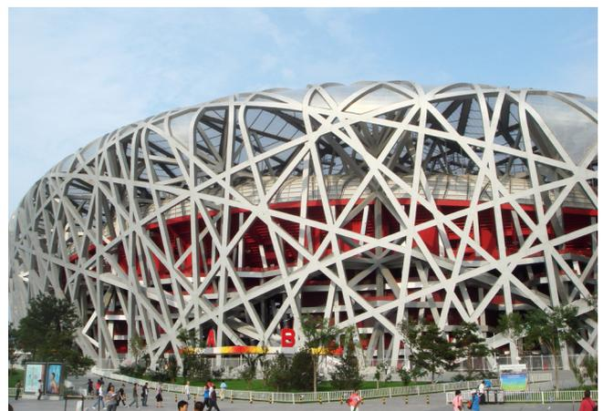
Abb. 2: Äußeres Metallstrebenwerk des Olympiastadions in Peking
