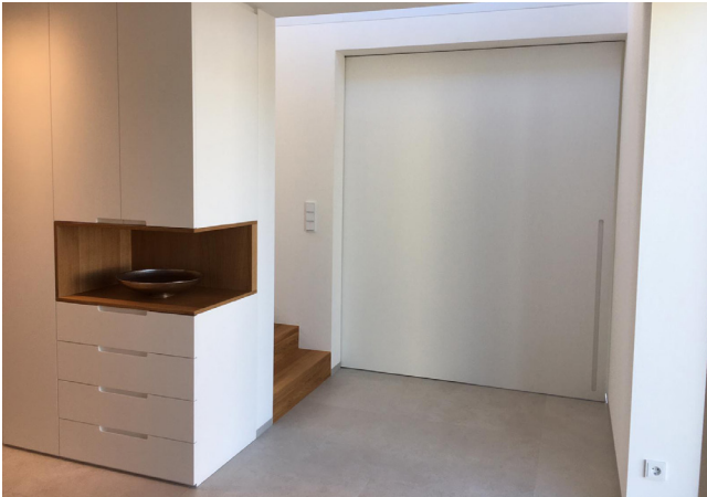
Abb. 4: Maßgefertigte Elemente im Innenausbau: Schrankschrank, Treppenstufen, Schiebetüre
